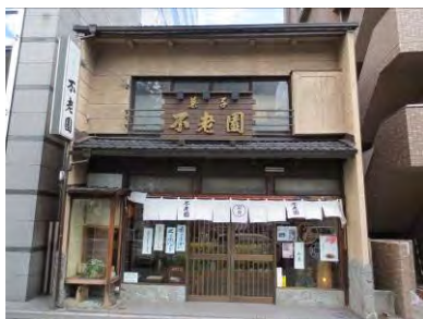
昭和30年築 店舗 中区古渡町11-32 H24.9.19
